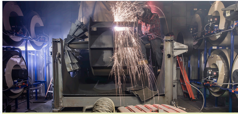
▲ Old Fan Removal
